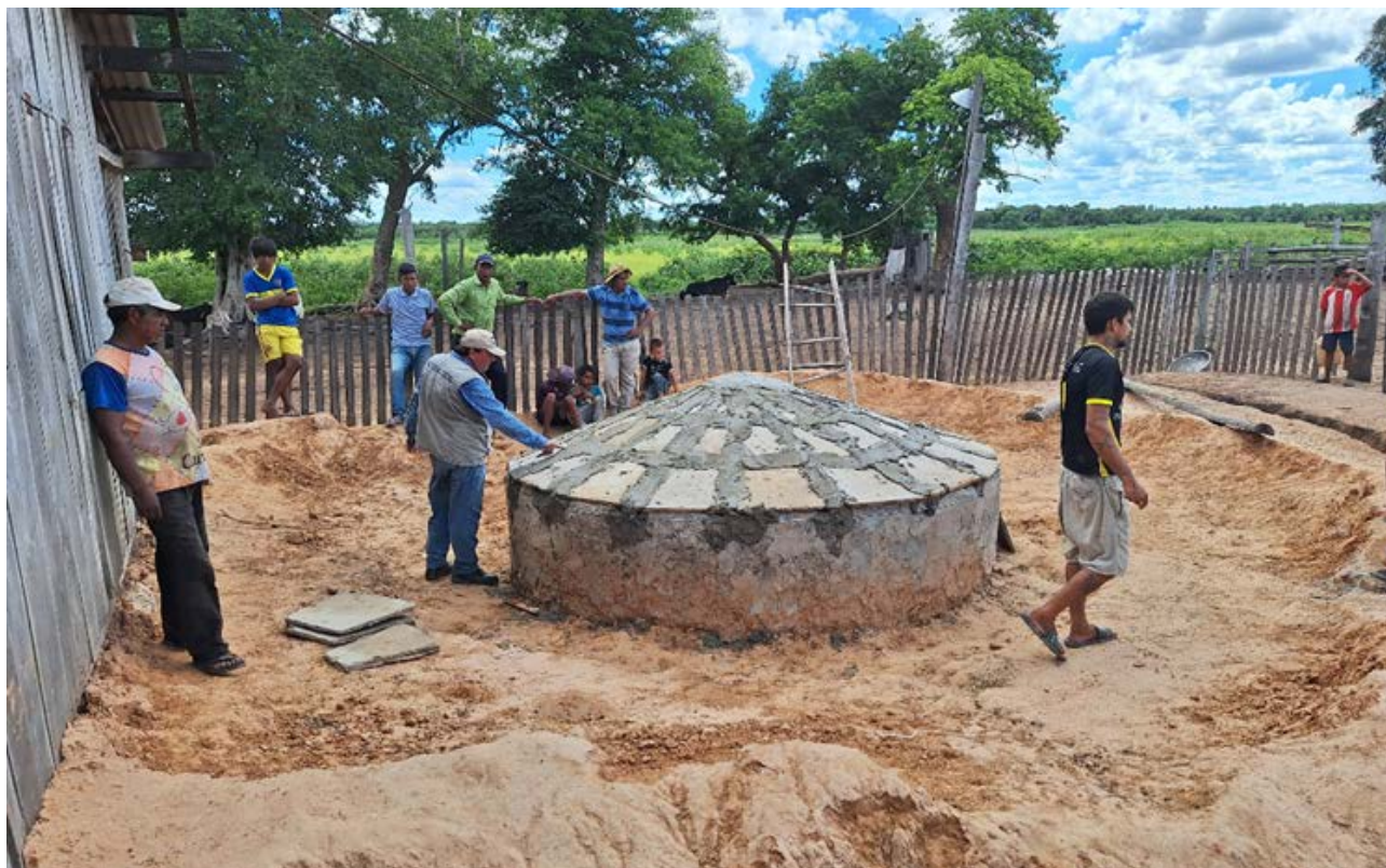
Fotografía 38. Construcción de aljibe en el Chaco
