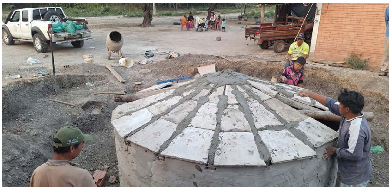
Fotografía 69. Construcción comunitaria de aljibe en el Chaco
