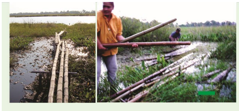
Fotografía 66. Proceso de preservación de las varas de bambú
