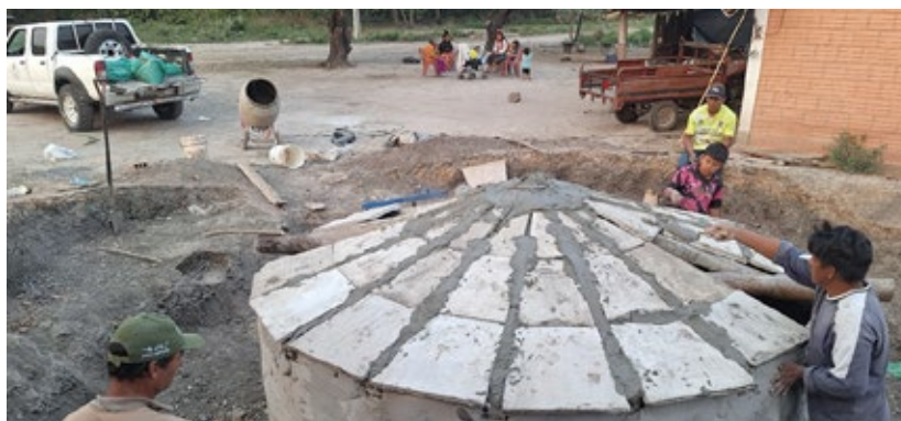
Fotografía 69. Construcción comunitaria de aljibe en el Chaco
