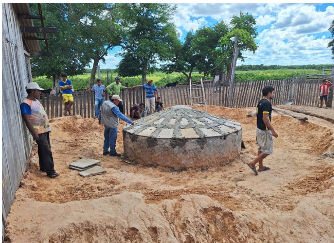
Fotografía 38. Construcción de aljibe en el Chaco
